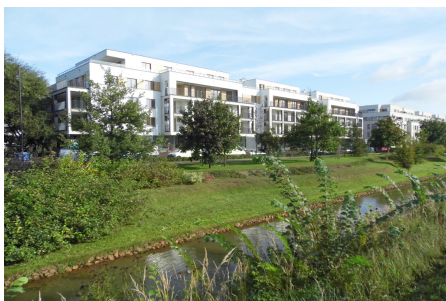
Ostoja-Wilanów (etapa 8, edificio B2). Fecha de entrega: Octubre de 2017. Nº de unidades: 43 viviendas y 3 locales comerciales (4,981 m 2 ). Prevendido: 98% (a 31 de marzo de 2018).
